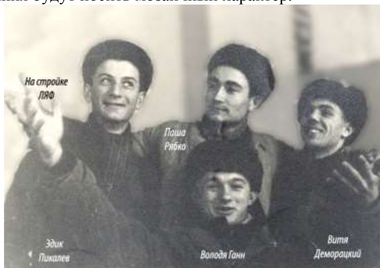
Фото 12 Будущие теоретики на стройке ЛЯФ
